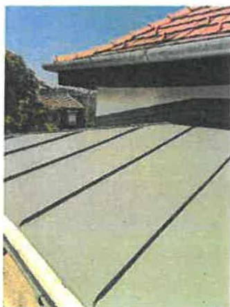
Tigris bölcsőde – új bádogozás és tető alatti lambéria csere, átadó előtti folyosó burkolatcsere
